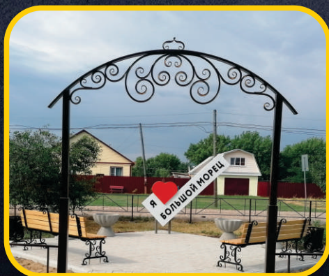
строительство площадки для отдыха
