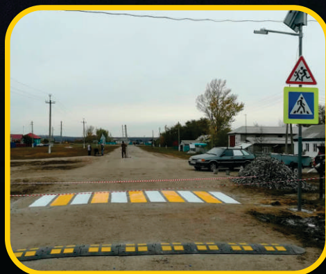
обустройство пешеходного перехода
