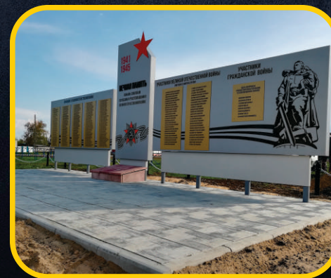
строительство памятника, благоустройство территории
