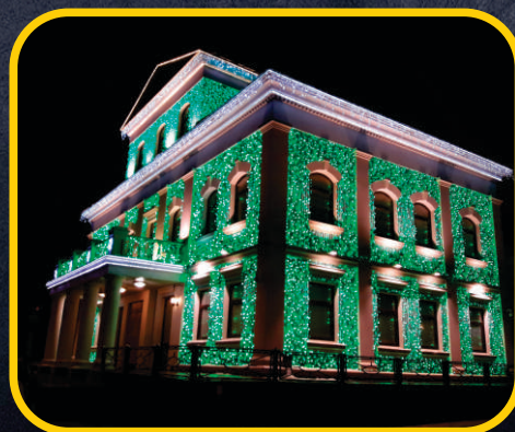
декоративное освещение здания ДК
