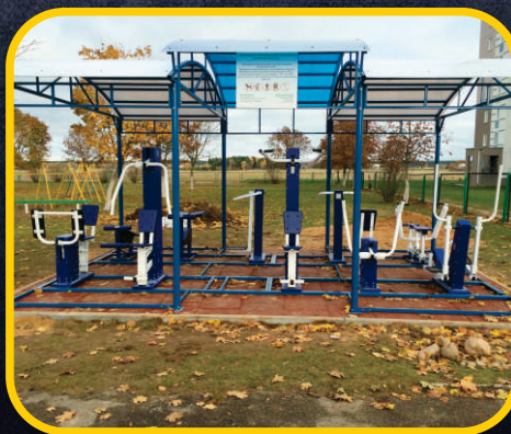
обустройство уличной спортивной площадки
