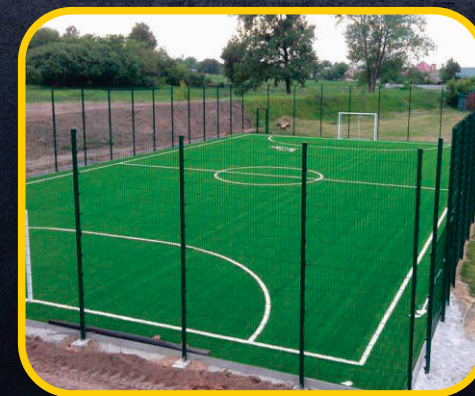
обустройство площадки для мини-футбола
